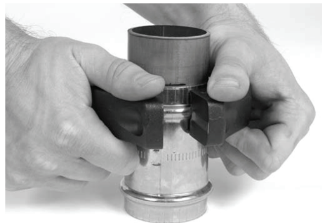
图8 将转换压接环安装到管件上
